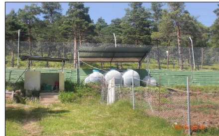
İçme ve Kullanma Suyu Hattı Çekilmesi
