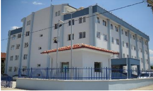
Erbaa İlçe Emniyet Müdürlüğü İnşaatı
