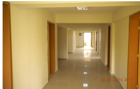
Karşıyaka Lojmanları Hizmet Binasına Dönüşüm İnşaatı
