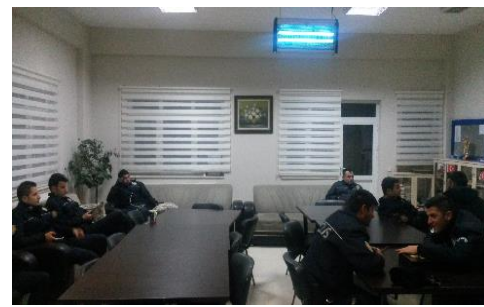
Çevik Kuvvet Binası İç Tadilatı
